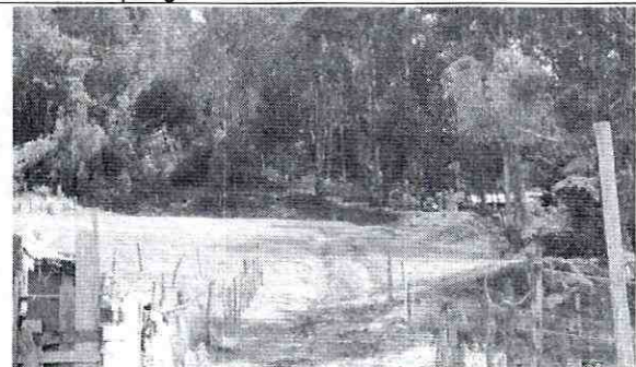
Fotografía N° 6. Se observa en el fondo, la falla de un muro de cerramiento de una finca, debido a un deslizamiento, se aprecia un escarpe en el costado izquierdo de la fotografía. Proceso que se presenta al suroriente del polígono.
