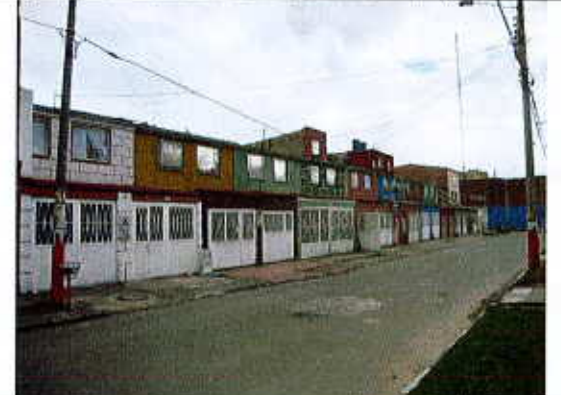
Fotografía No. 8: Manzana: 07. Frente: KR 9 A (Sector Catastral Sociego). Se observa uso residencial con ocupación de áreas de antejardín y adecuaciones de un nivel más en altura.
