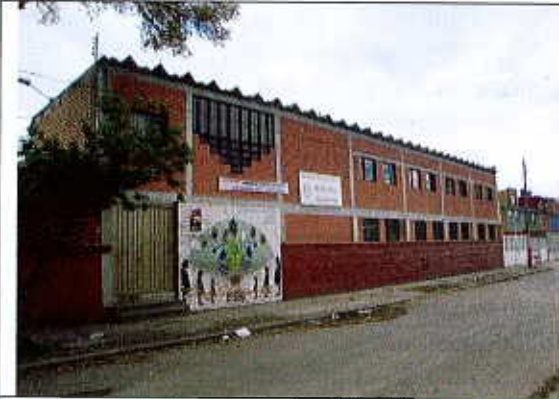
Fotografía No. 5: Manzana: 07. Frente: KR 9 A (Sector Catastral Ciudad Jardín). Se observa la presencia de uso dotacional relacionado con un equipamiento colectivo educativo. De igual manera, procesos lesivos en andén y buen estado de la calle vehicular.
