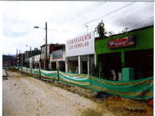
Fotografía No. 9: Manzana: 80. Frente: AK 10 (Sector Catastral Ciudad Jardín). Se observa obra en infraestructura y presencia de usos de comercio (vecinal) y de servicios (de logística, técnicos especializados).
