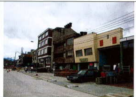
Fotografía No. 6: Manzana: 77. Frente: AK 10 (Sector Catastral Ciudad Jardín). Se observa la presencia de diversidad de usos residencial, comercial y de servicios. De igual manera, ocupación de espacio público y obras en infraestructura (en calle y en andén).
