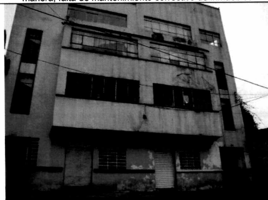
Fotografía No. 7: Manzana 08. Frente Carrera 6
