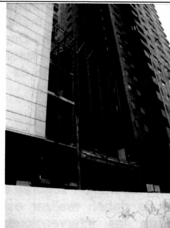
Fotografía No. 10: Manzana 12. Frente Carrera 7ª Factor CN: Se observa obra en etapa de demolición parcial y en etapa de estructura
