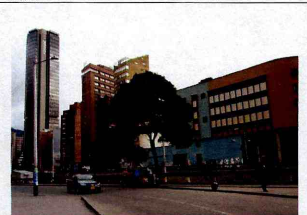
Fotografía No. 6: Se observa presencia de edificaciones de gran altura con usos de servicios y residencial. Igualmente, edificaciones sin uso y en proceso de deterioro.
