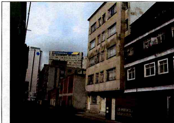
Fotografía No. 1: Se observa uso residencial y de servicios personales, adecuaciones y deterioro leve en fachadas y andenes.
