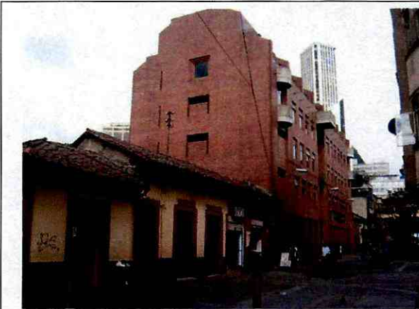
Fotografía No. 3: Se observa uso dotacional y de comercio vecinal en edificaciones desarrolladas en diferentes épocas. Igualmente, calle peatonal en buen estado.
