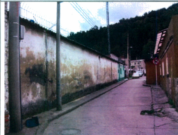
Foto # 1 Panorámica de la Calle 101, se observa pendiente suave del terreno y presencia de edificaciones obsoletas.
