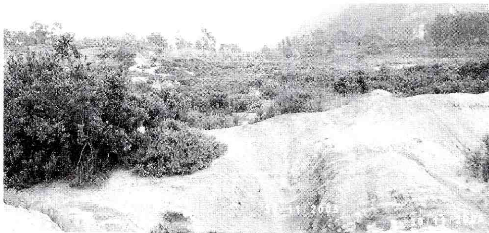
Fotografía N° 7. La que se observa es erosión avanzada tipo carcavamiento en estratos competentes (areniscas). CT 4272 – PREDIO “HACIENDA EL TABLÓN”
