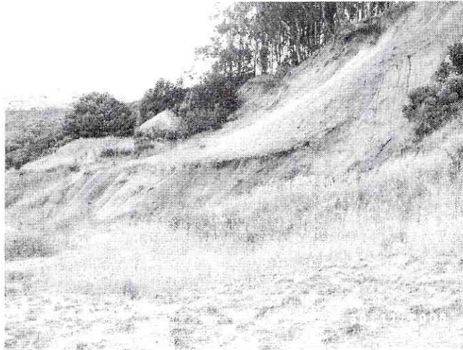
Fotografía N° 6. Imagen que da una idea de las zonas de erosión en surcos.
