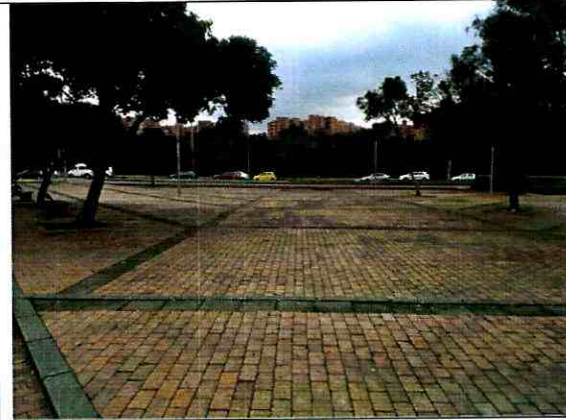
Fotografía No. 2 Zona de posible inundación por desbordamiento del canal Molinos en la Carrera 55 con Calle 116
