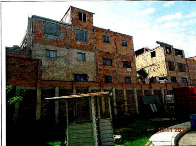
Fotografía 5. Cerramiento del patio, hacia el costado occidental, contra las culatas de las viviendas del sector.
