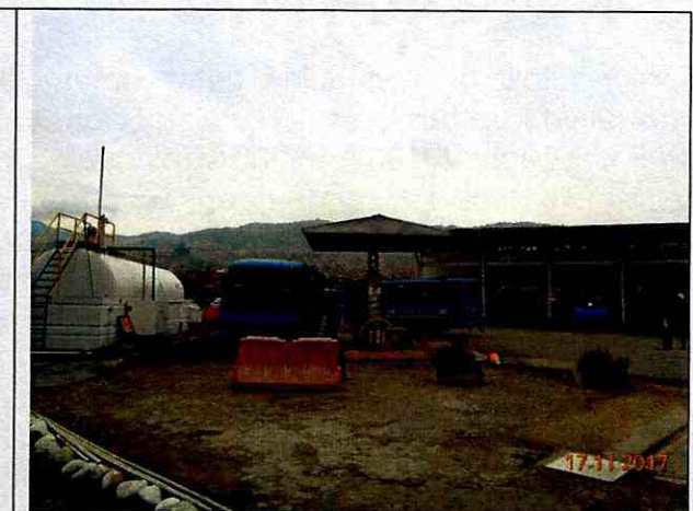
Fotografía 4. Estación de servicio de combustible, para abastecimiento de los buses de la flota del Sitp.
