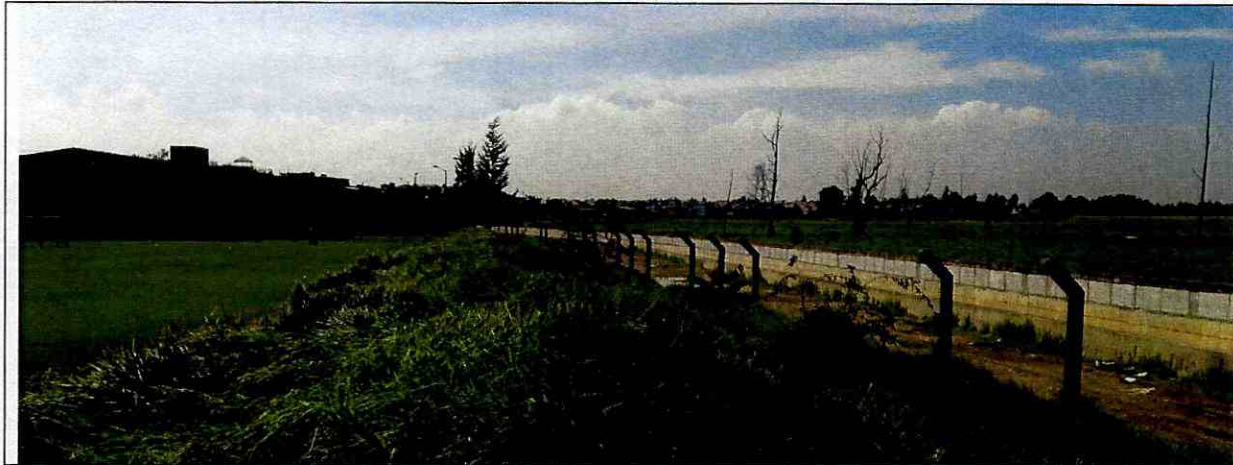
Fotografía 2. Panorámica vista hacia el Sur, donde se aprecia el canal Marantá hacia el occidente, separado de las canchas de fútbol por un jarillón, y al fondo, las construcciones correspondientes a bodegas de la ETB.
