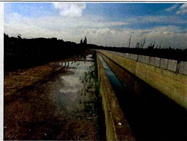
Fotografía 4. Canal Marantá, visto hacia el sur, separado de la cancha de fútbol por vía y terraplén.
