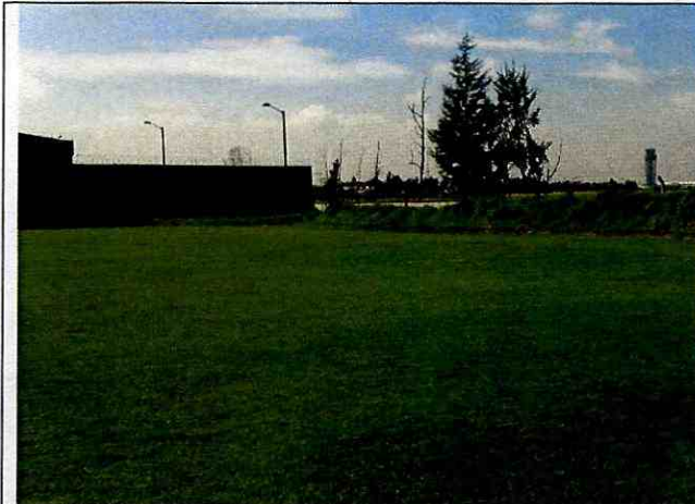
Fotografía 3. Cancha de fútbol, localizado en una cota inferior al Canal Marantá. Al fondo, izquierda se observan las bodegas de la ETB.
