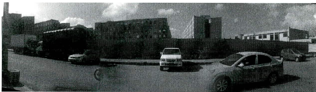
Fotografía 4. Panorámica exterior del predio objeto de consulta, se observa el cerramiento provisional en Polisombra
