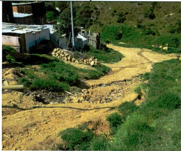
Fotografía 6. Vista de los desagües de las viviendas aledañas al polígono del Proyecto Parque Vecinal Desarrollo Caracolí- 30 de mayo de 2017
