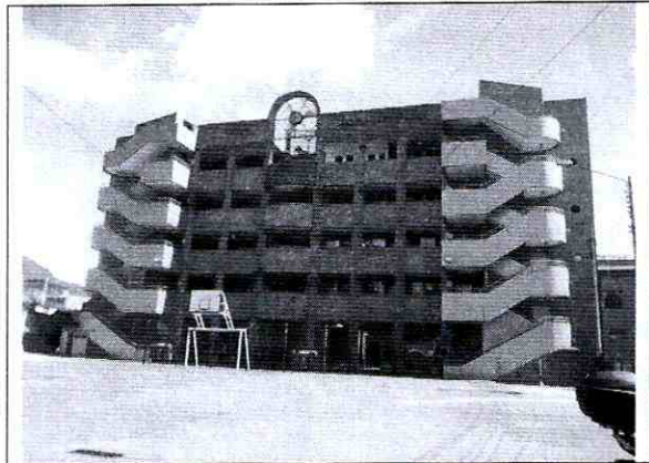
Fotografía 3. Edificación principal del Colegio Jaime Pardo Leal
