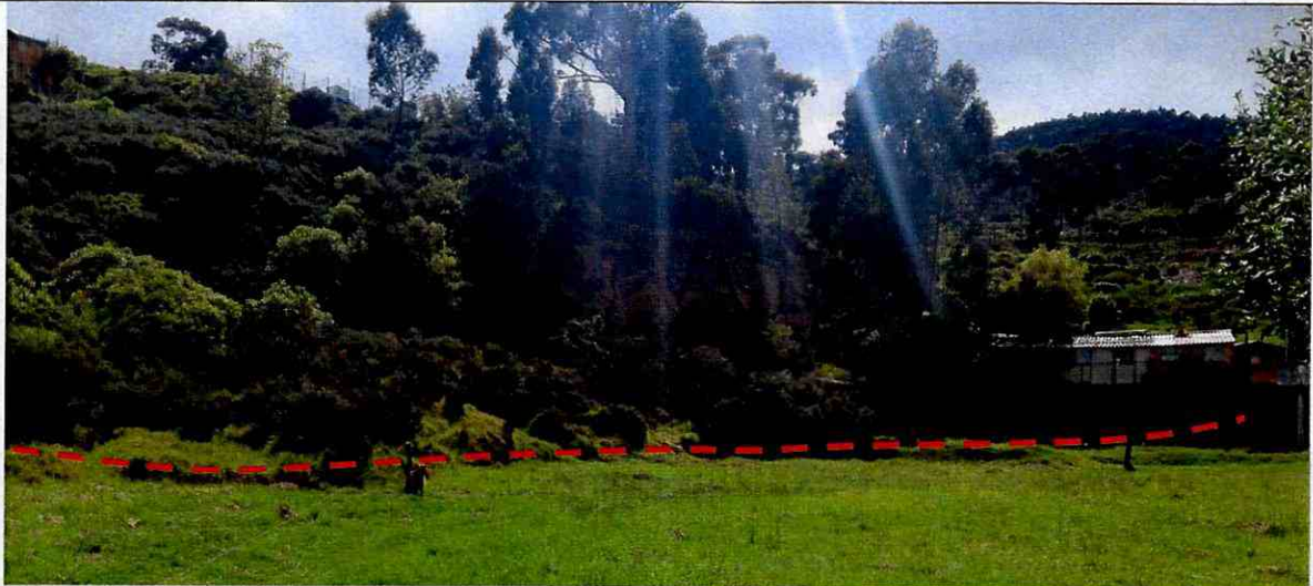
Fotografía 8. Se aprecia el sector de la ladera localizada al norte del predio. La línea delimita aproximadamente el sector que se recomienda restringir y definir como zona de amortiguamiento frente a los procesos de inestabilidad identificados.
