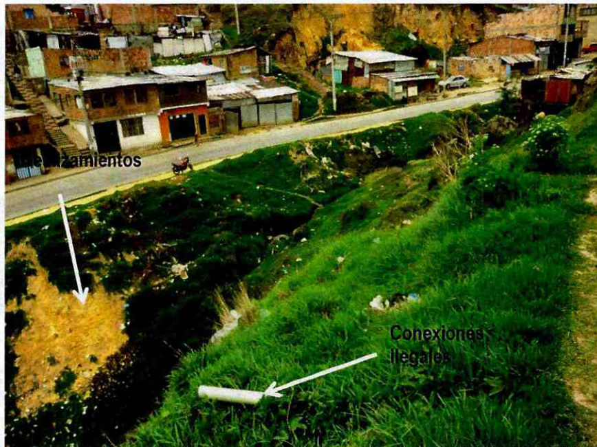
Foto 5. Se observa conexiones ilegales de aguas residuales, basuras y deslizamientos locales en la parte baja de la quebrada Honda.
