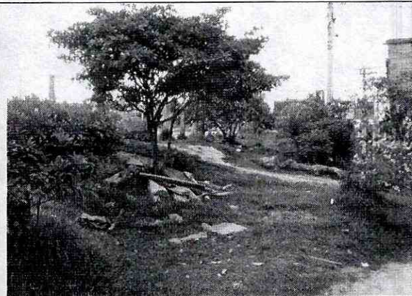
Fotografía No.2. Adecuación de zona verde en la Cr5 entre Cll 71C Sur y Cll 71D Sur.
