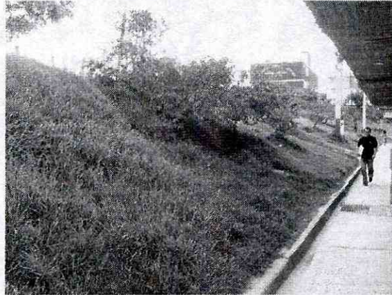
Fotografía No.3. Talud que limita la zona verde ubicada en la Cr5, entre Cll 71C Sur y Cll 71D Sur.
