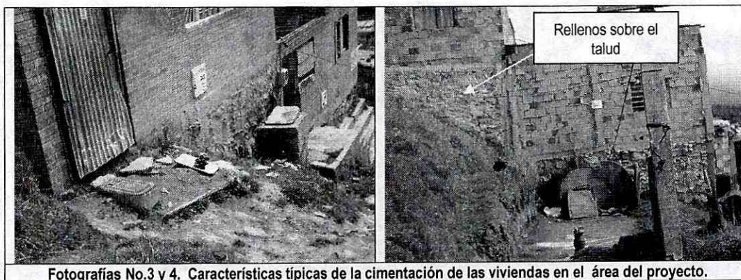
Fotografías No.3 y 4. Características típicas de la cimentación de las viviendas en el área del proyecto.
