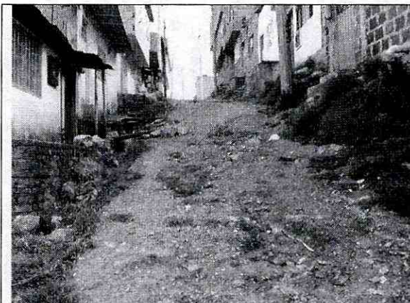
Fotografía No.1. Construcción de paso peatonal en la Cr18A Bis.
