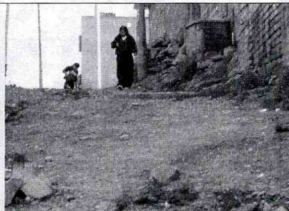
Fotografía No.2 Construcción de paso peatonal en la Cr18A Bis.
