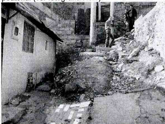
Fotografía No.1. Construcción de paso peatonal cerca de la carrera 18J.
