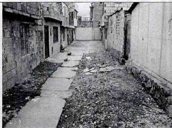
Fotografía No.4. Vista a vía proyectada para peatonalización
