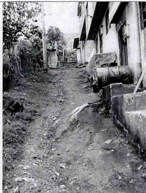
Fotografía No. 2. Vista a vía proyectada para peatonalización
