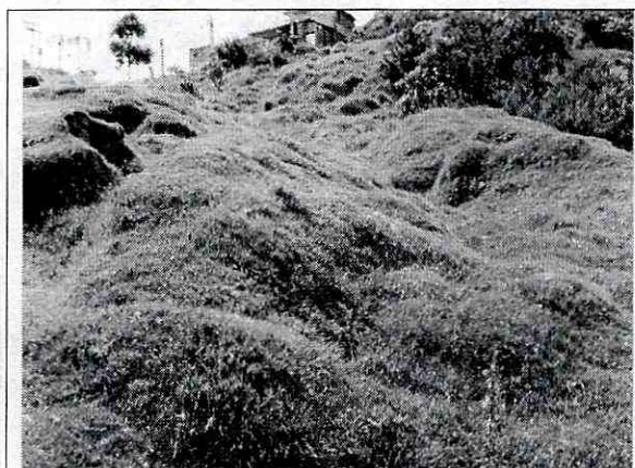
Fotografía No. 5: Procesos de reptación identificados
