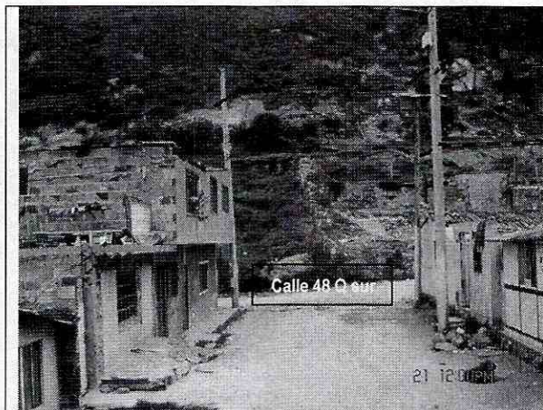
Fotografía No.3. Al fondo de la fotografía se observa la calle 48 Q sur que se podría ver afectada por la reactivación del deslizamiento de Nueva Esperanza.
