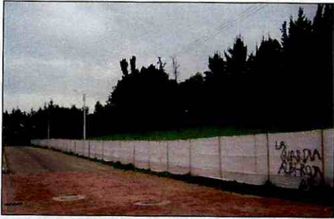
Fotografía 3 Vista sur occidental de la Etapa III
