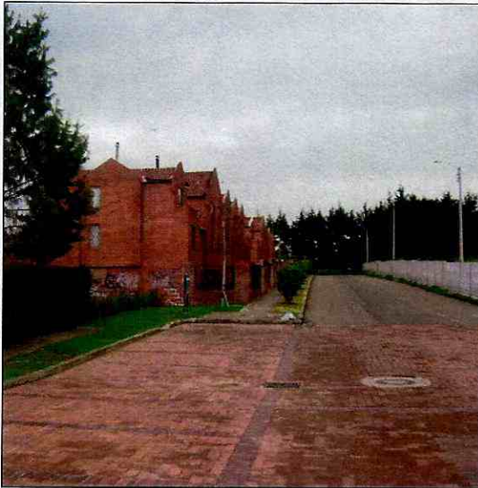
Fotografía 5 Límite occidental de la Etapa III
