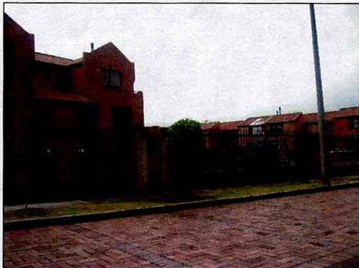
Fotografía 1 Vista general costado sur occidental
