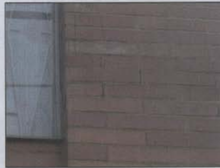
Fotografía 17 Grieta escalonada en el muro fachada del segundo piso de la casa de la Calle 33 Bis Sur # 93 - 13
