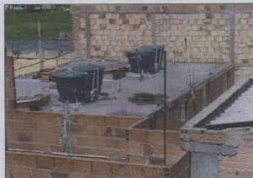
Fotografía 2 Detalle de la cubierta original de las viviendas
