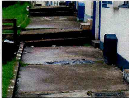
Fotografía 5 Hundimientos del andén sobre la Transversal 4C entre las calles 36 y 36B sur
