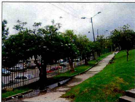
Fotografía 1 Inclinación de árboles y postes de luz y hundimiento del sendero peatonal en parque del sur de la urbanización
