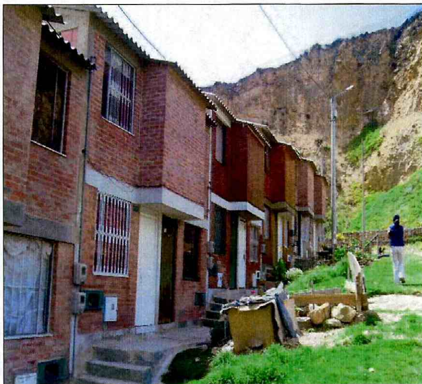
Fotografía 1 Vista general de las casas de la manzana 5 ubicadas sobre la Carrera 72 Sur y la proximidad del escarpe ubicado al sur de las manzanas 4 y 5
