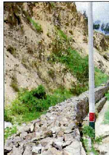
Fotografía 7 Detalle del muro en gaviones ubicado en la base del escarpe
