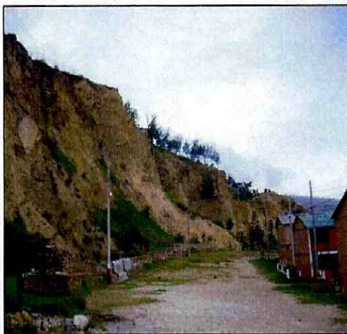
Fotografía 6 Panorámica del escarpe ubicado al Sur de las manzanas 4 y 5
