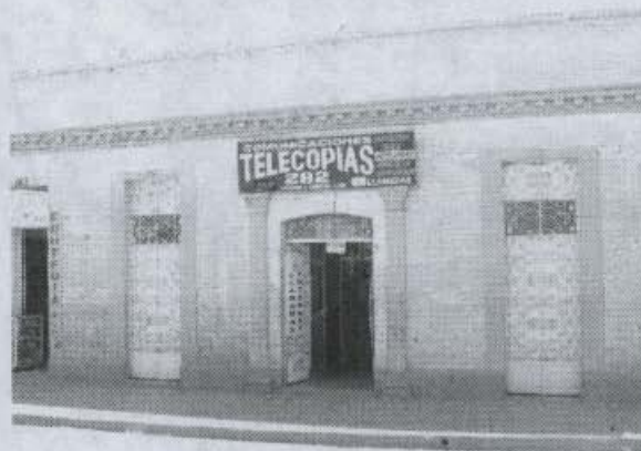
Fotografía N° 1. Aspecto de la fachada sobre la carrera 7 del Conjunto Residencial Santa Bárbara Central IV Etapa.
