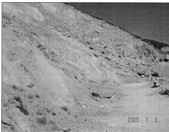
**Foto No. 3.** Se observa el buzamiento de los estratos rocosos en el predio.
