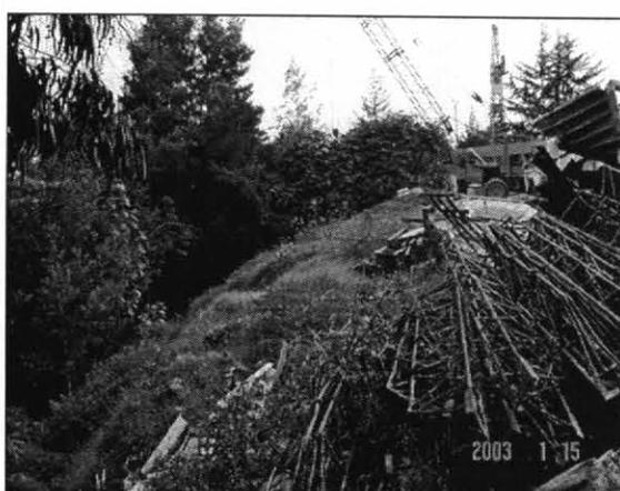
**Foto No. 6.** Obsérvese la altura e inclinación del relleno ejecutado para conformar el patio de máquinas.
