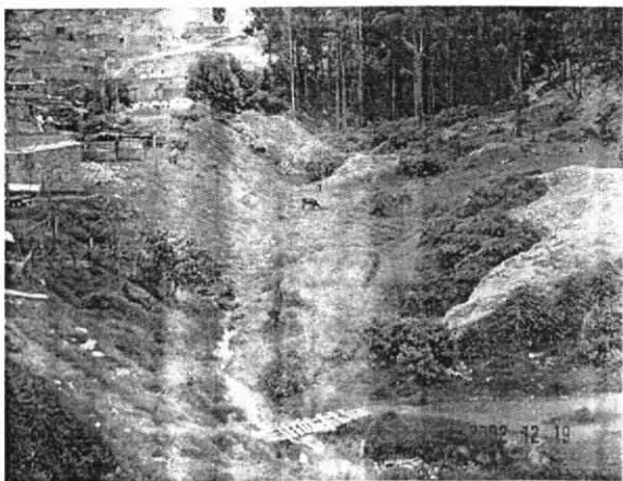
Foto No. 3. Vista del cauce aguas arriba de la quebrada la Olla del Ramo
