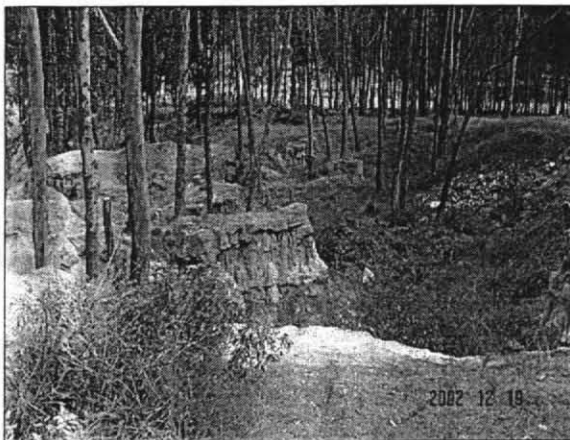
Foto No. 4. Se observa una de las cárcavas formadas en la margen derecha de la quebrada la Olla del Ramo.
