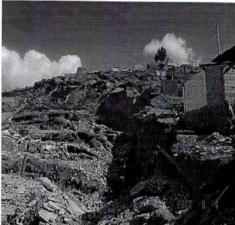
Foto 1. Escarpe principal del deslizamiento en el B, Cerro del Diamante.
