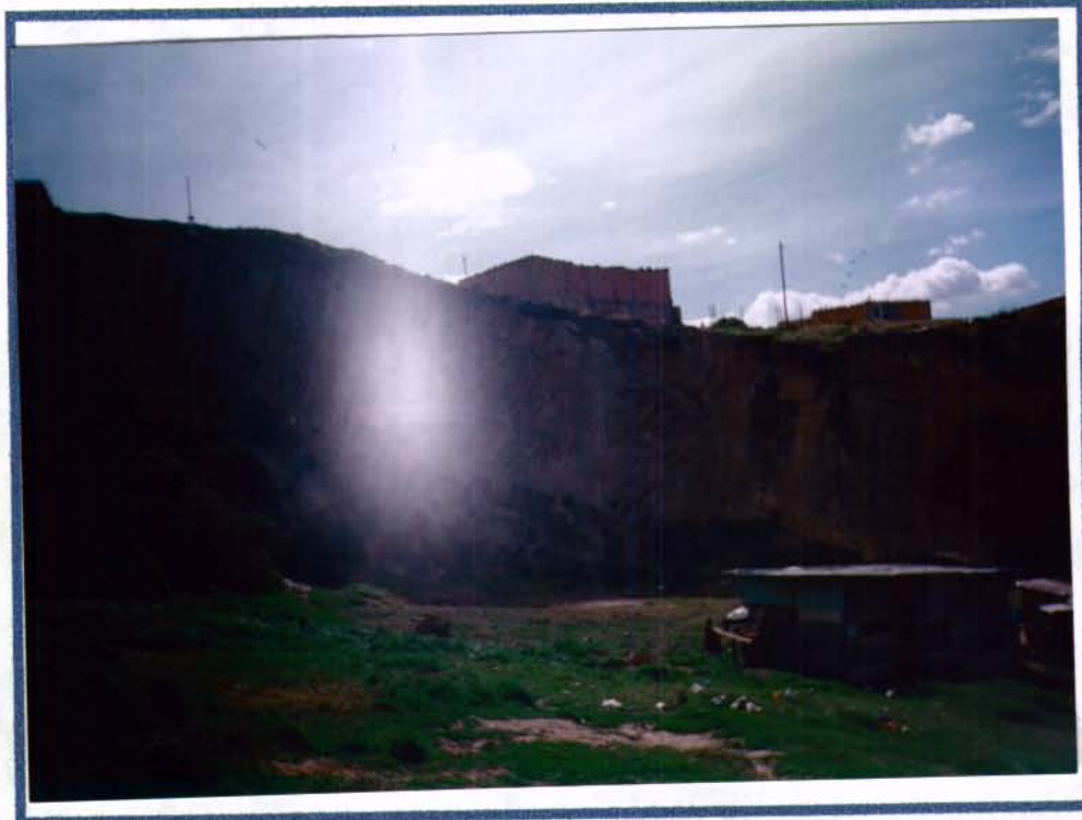
Foto 3 Talud del sector B
