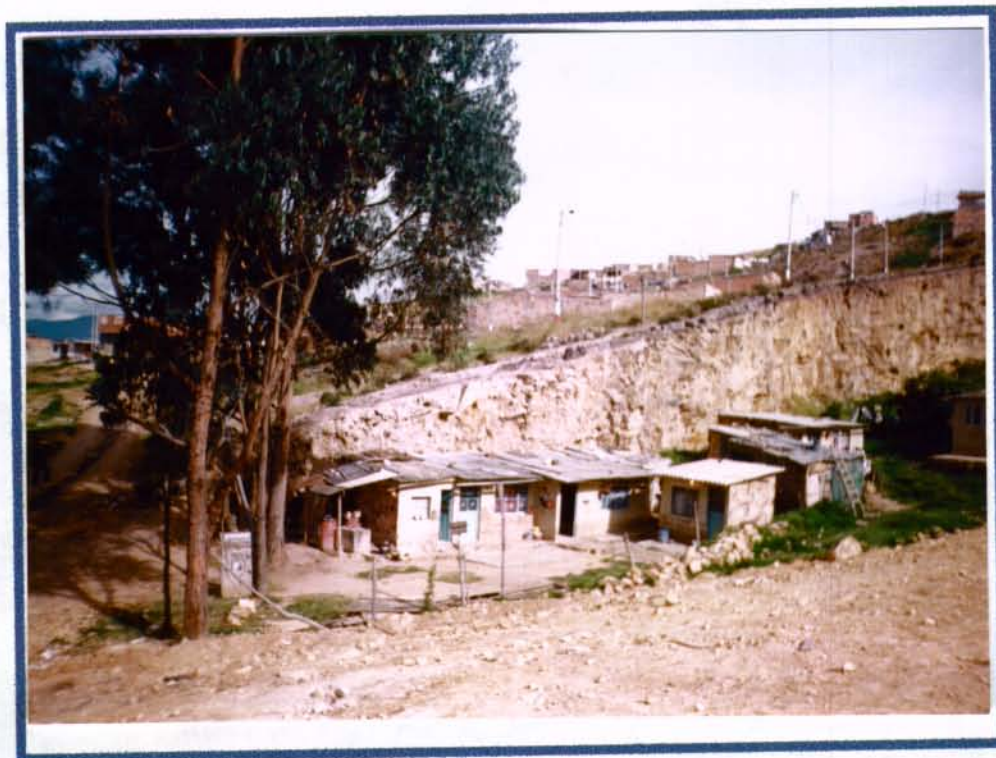
Foto 7 Sector D, casas semiconsolidadas expuestas a la amenaza por caída de bloques del talud de la antigua cantera.
