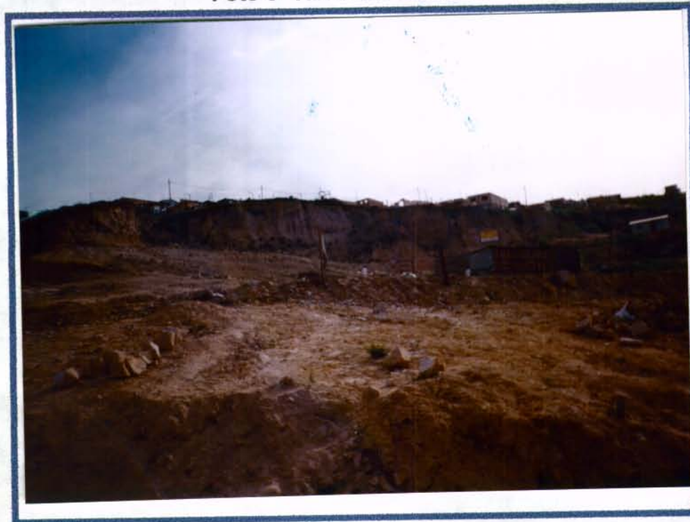
Foto 4 Sector C Talud con una altura de aproximadamente 5 m. muy fracturado y en su pata hay una pendiente de aproximadamente 22 °.
