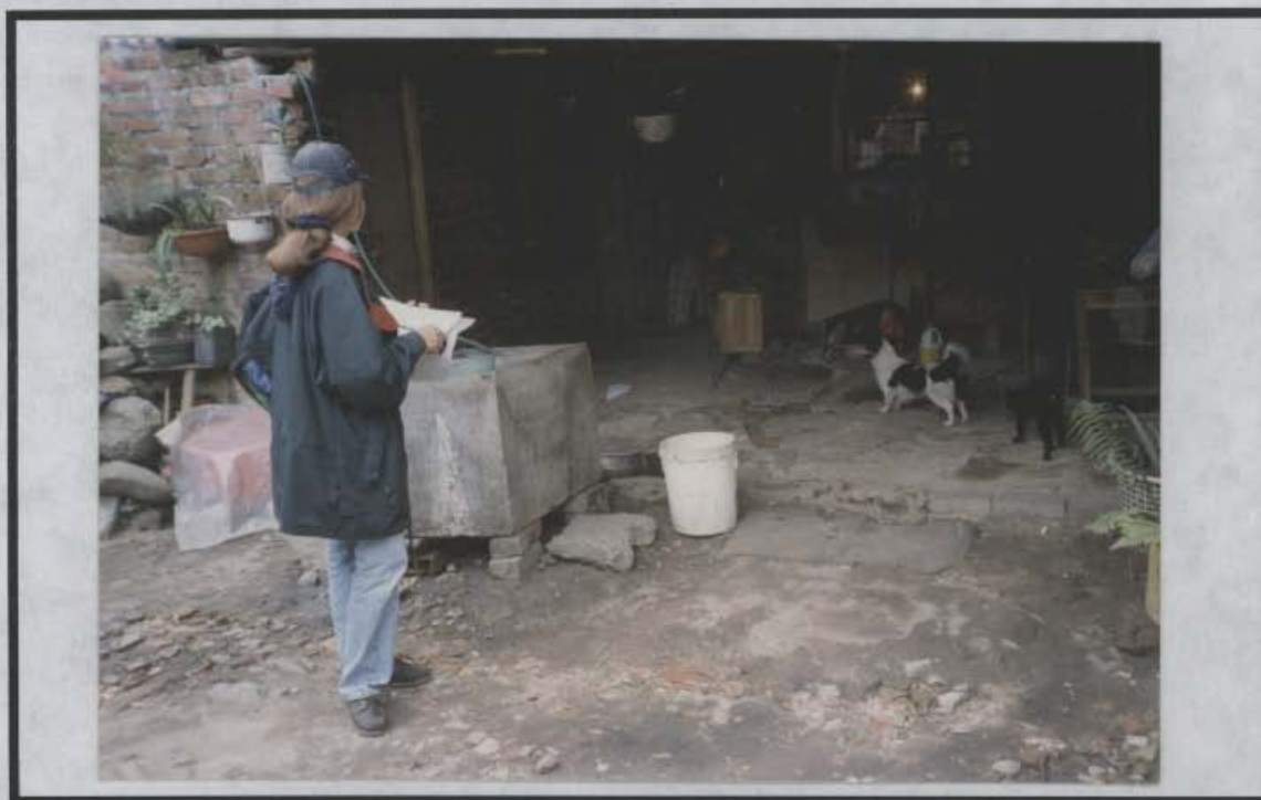
R-8713 F-11 VIVIENDA PARCIALMENTE DESTRUIDA, PRESENTA GRIETAS DE TRACCION EN LOS PISOS Y PAREDES PRODUCIDO DE LA INESTABILIDAD DE LA ZONA.
