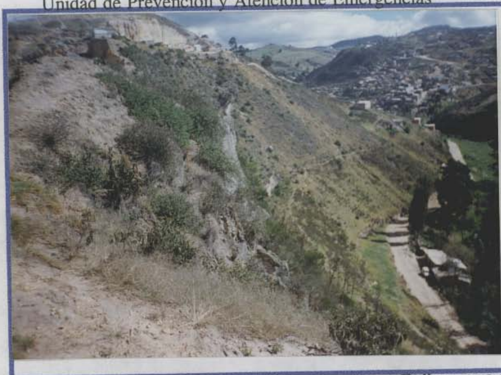
Foto 5 Casa 1 edificada al borde de la antigua carretera a Quiba y que esta amenazada por el bloque crítico de la foto anterior.
