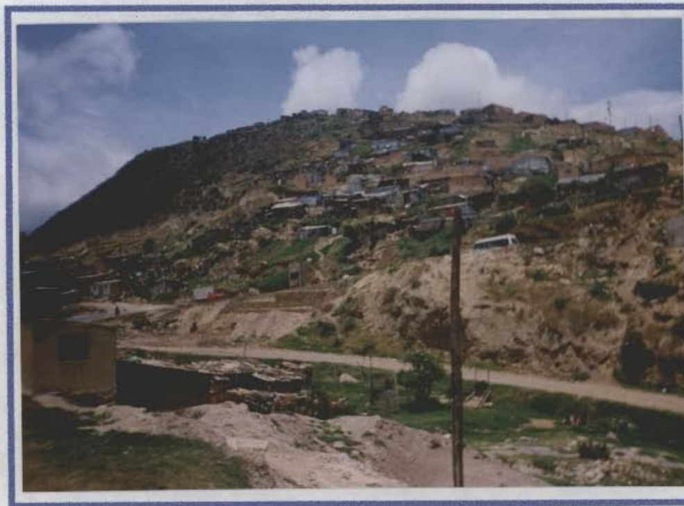
Foto 3 Talud 2, observese su pendiente y los muros de contención
