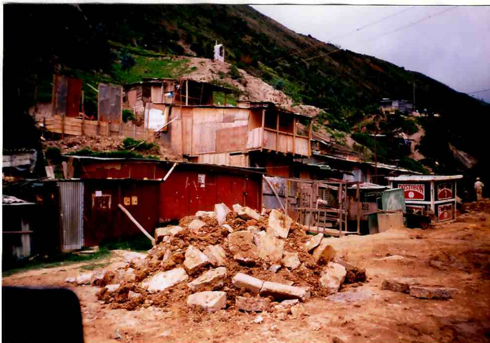
Fotografía No.2. Detalle de la construcción antitécnica de las viviendas, lo cual genera la mayoría de los problemas de remoción en masa del sector.
