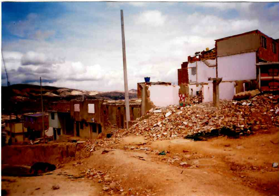
Fotografía No. 2. Casas del barrio Playón-Playita en proceso de demolición. Los propietarios de dichas viviendas no concluyeron con este proceso, generando un problema de seguridad pública a los habitantes que quedan en el barrio.
