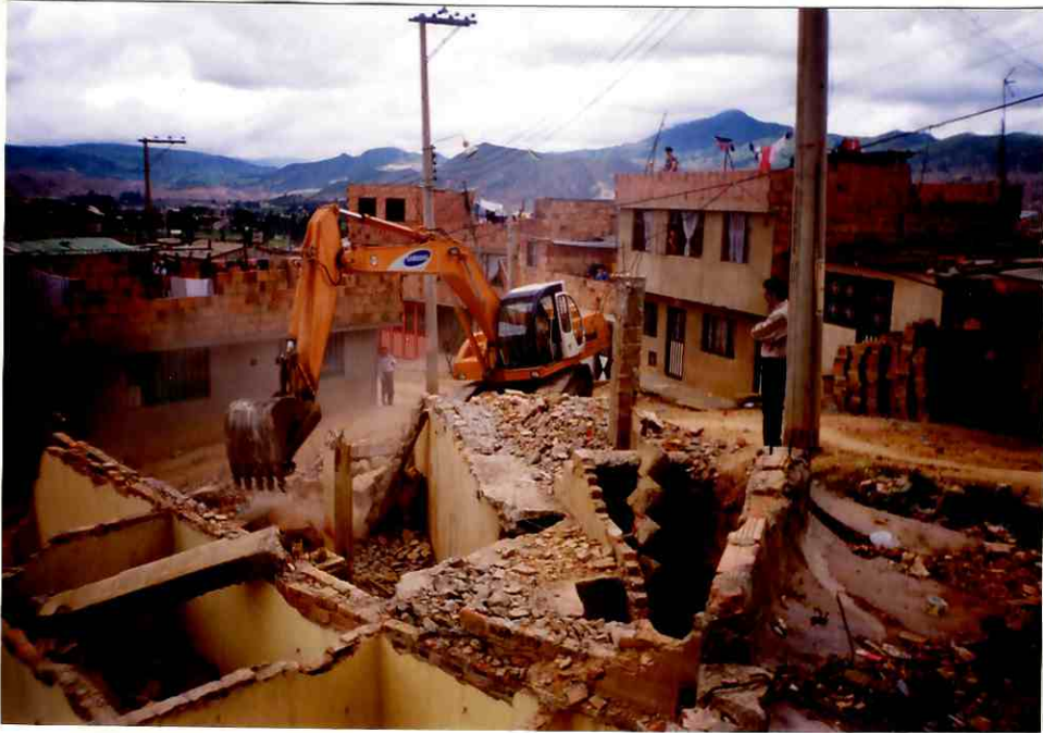
Fotografía No. 1. Detalle del proceso de demolición efectuado en los meses de Abril y Mayo de 1998, con la ayuda de la Secretaría de Obras Públicas.
