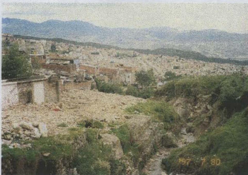
FOTO 2. Quebrada El Zuque. Obsérvese en la margen izquierda muro de gaviones donde ya fueron reubicadas algunas viviendas.
