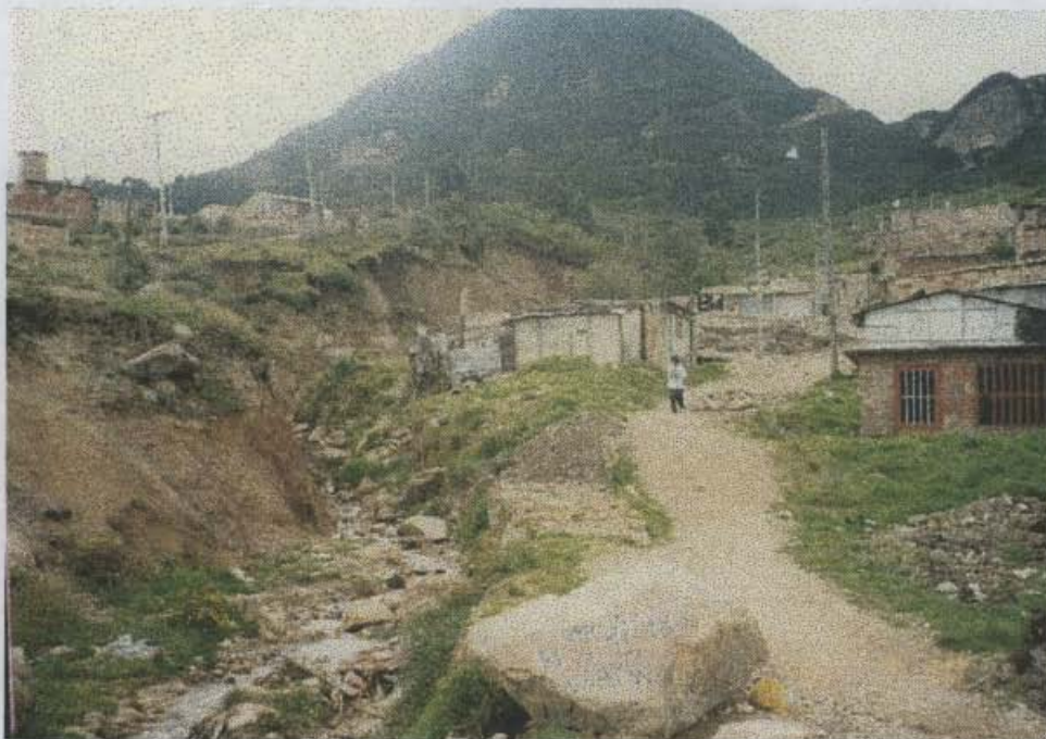
FOTO 1. Quebrada el Zuque. Vista general del cauce. Obsérvese los deslizamientos en la margen derecha y las viviendas localizadas en la ronda.
