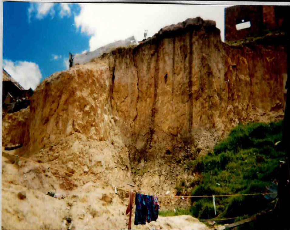
FOTO No. 1 CONCEPTO No.2707 DESCRIPCIÓN: Obsérvese el alto grado de alteración y fracturamiento de la roca; sin embargo, esta presenta buena capacidad portante. LOCALIZACIÓN: Cra 5L con Cllé 48Q Sur, Barrio Mirador de Marruecos, Loc. 18
