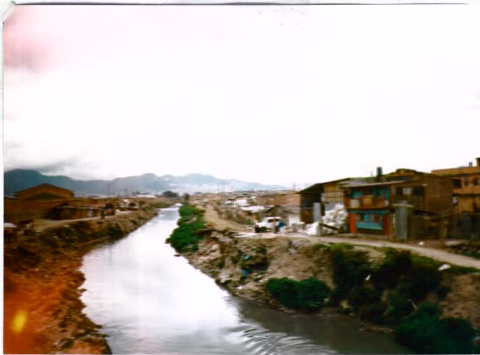
FOTO 1. Barrio El Vergel. Vista general del Río Fucha. Obsérvese las viviendas construidas sobre la ronda.
