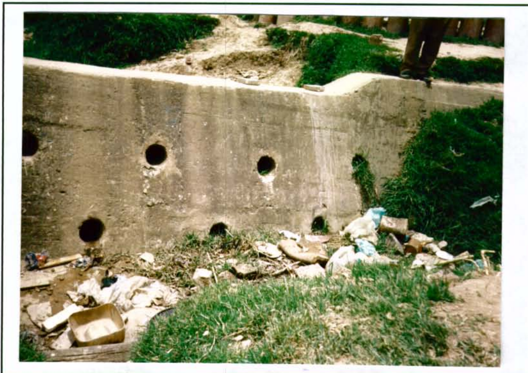
Obsérvese la estructura de drenaje obstruida.
