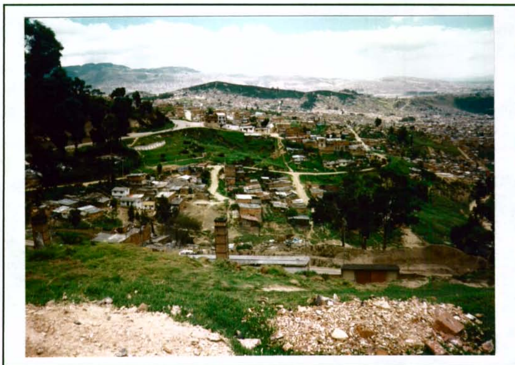
Vista general del sector.
