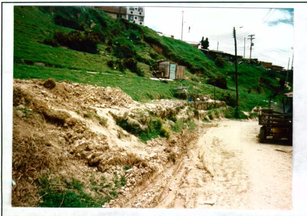
Obsérvese la inestabilidad de la ladera.
