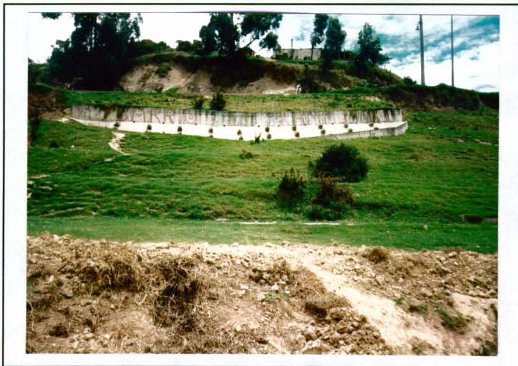
Obsérvese muro de anclaje.
