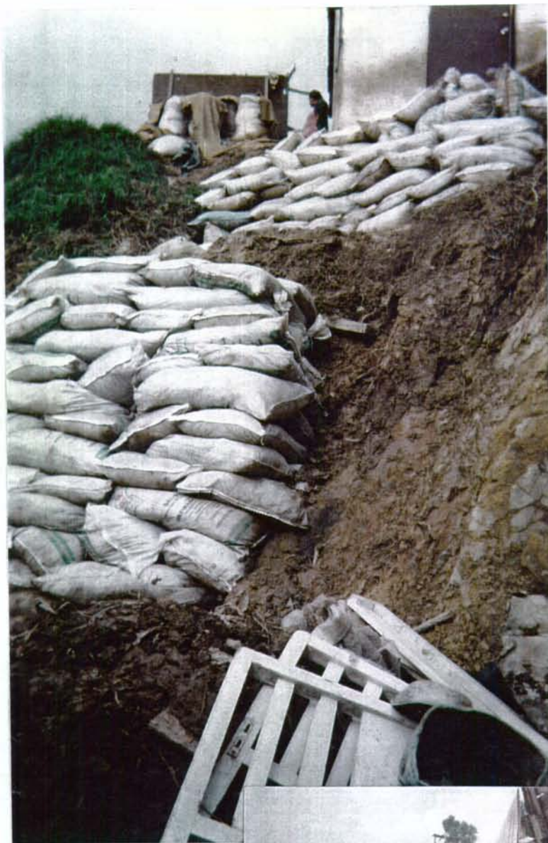
Foto No. 4. Inclinación de la vivienda con dirección Clle 2E # 7-30 Este por el escurrimiento lento de material.
