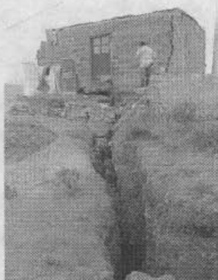
Fotografía 1 Grietas del terreno Mz 27. Se observa hundimiento del bloque oriental (derecho).
