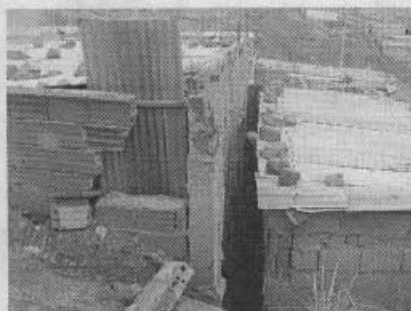
Fotografía 3 Mz 7 Lt 18 y 20. Se observa el deterioro en las construcciones por la presencia del agrietamiento principal en el límite de estos predios.
